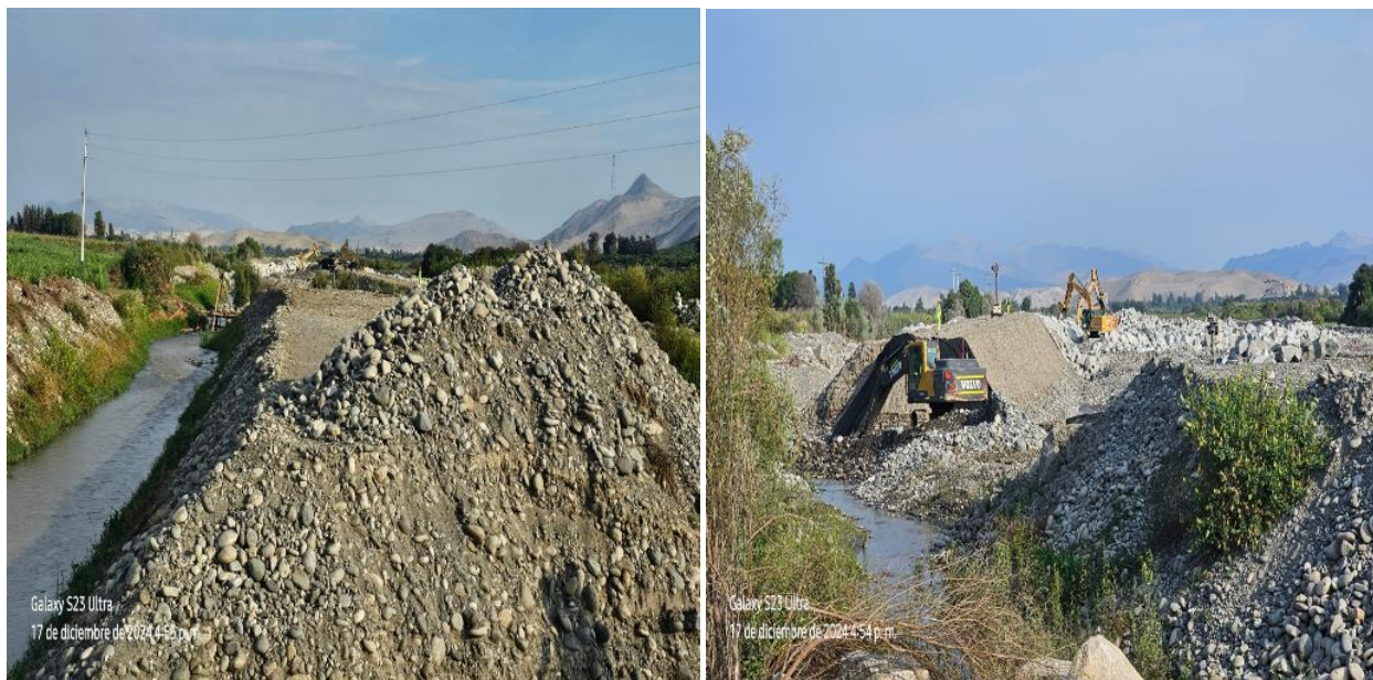
FOTOGRAFIA 02: Vista en la que se aprecia la carencia de diques secos con acumulacion de material propio en ambas margenes del río.
